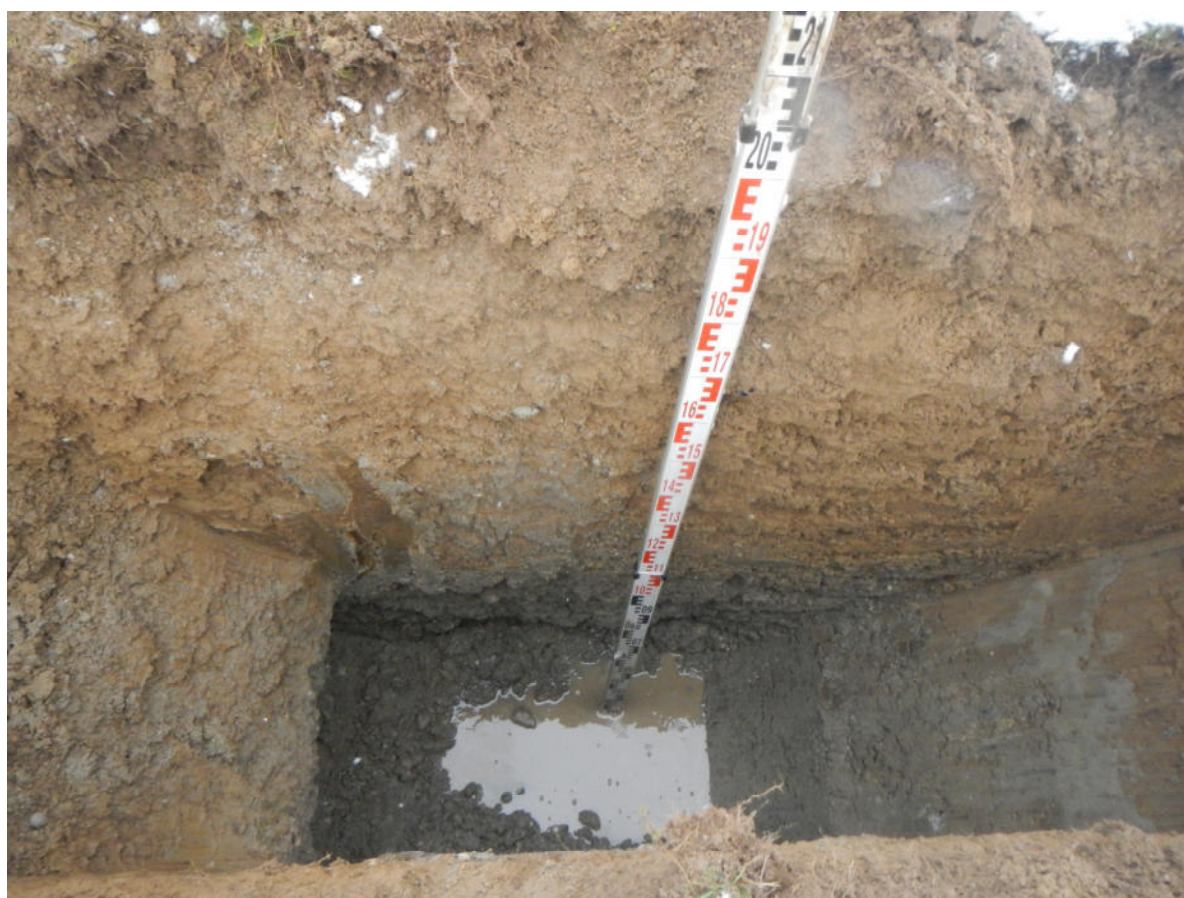
Foto 8: Baggerschurf BS 8 am 27.01.2021, Grundwasserspiegel bei 2,00 m u. GOK
