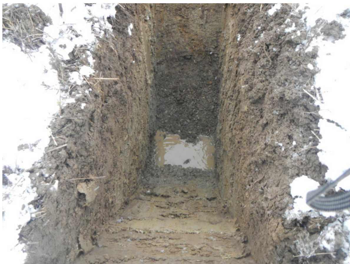
Foto 4: Baggerschurf BS 4 am 27.01.2021, Grundwasserspiegel bei 1,4 m u. GOK
