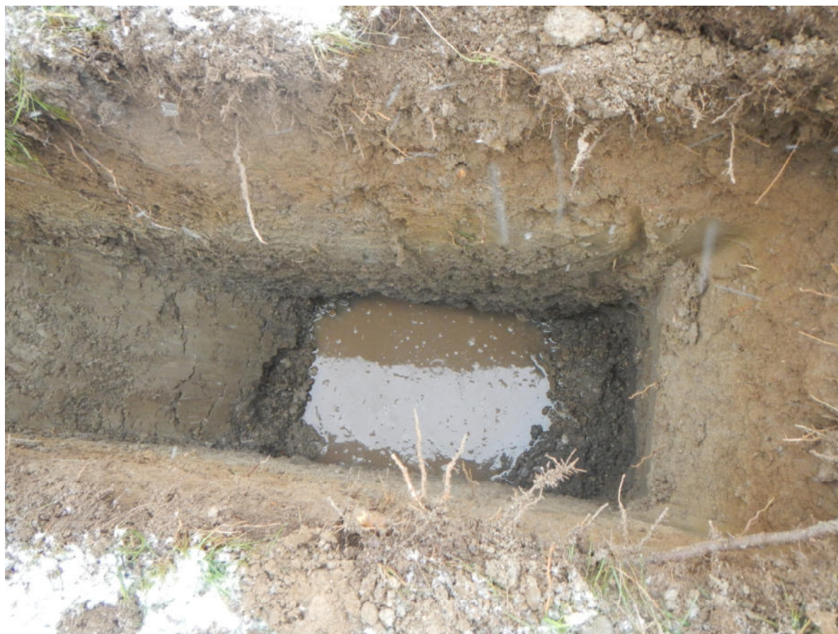
Foto 5: Baggerschurf BS 5 am 27.01.2021, Grundwasserspiegel bei 1,80 m u. GOK
