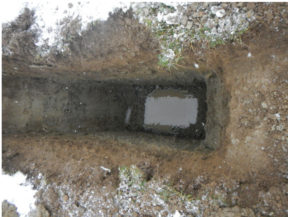
Foto 2: Baggerschurf BS 2 am 27.01.2021, Grundwasserspiegel bei 1,8 m u. GOK
