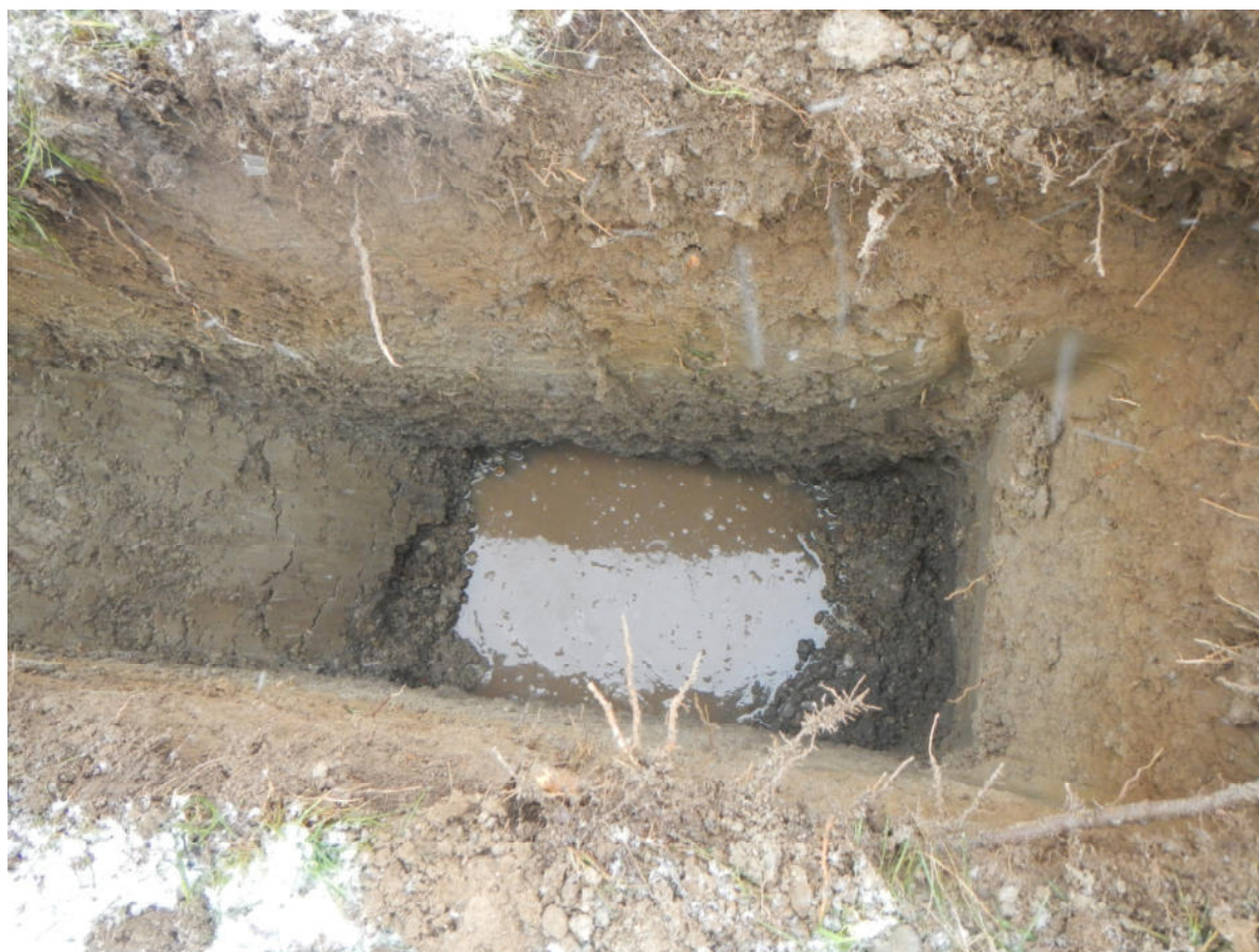
Foto 1: Baggerschurf BS 1 am 27.01.2021, Grundwasserspiegel bei 1,7 m u. GOK
