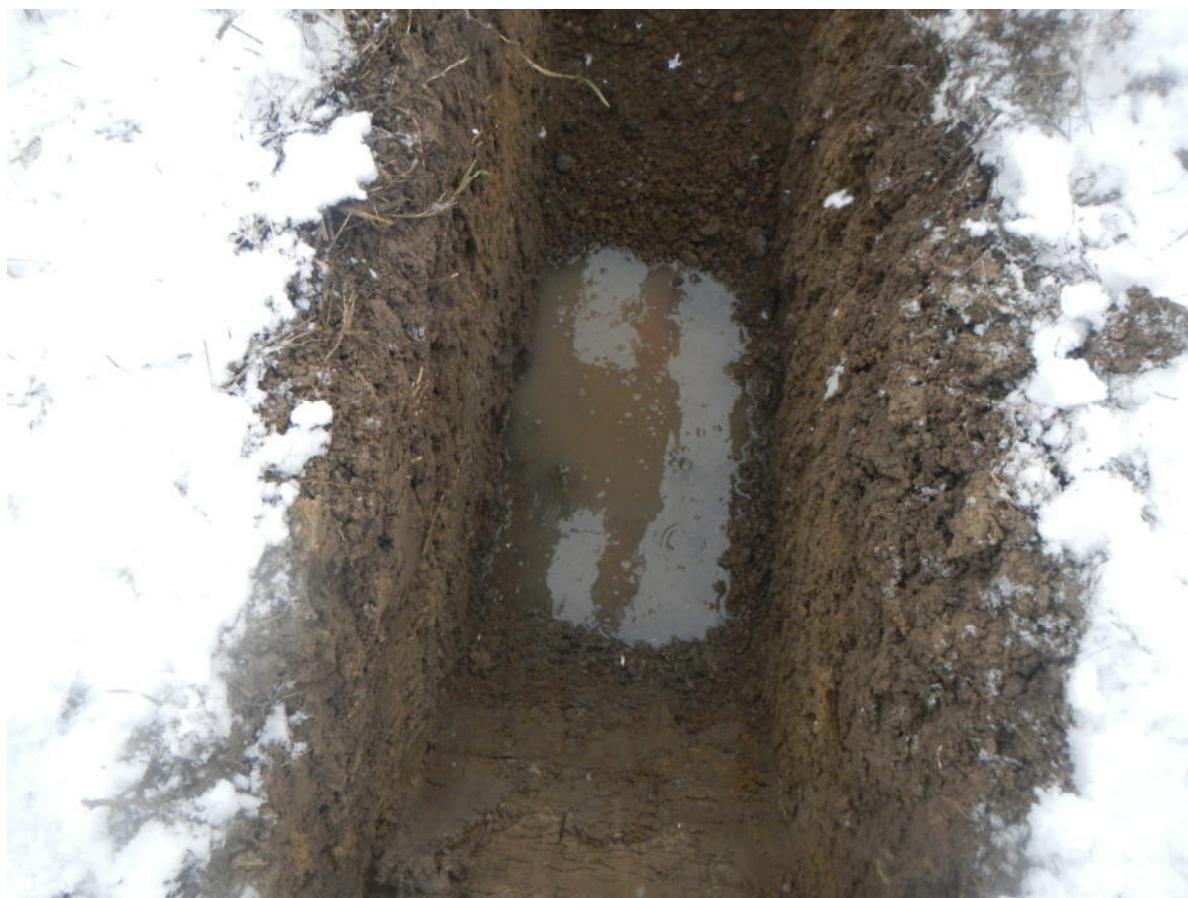
Foto 3: Baggerschurf BS 3 am 27.01.2021, Grundwasserspiegel bei 1,10 m u. GOK
