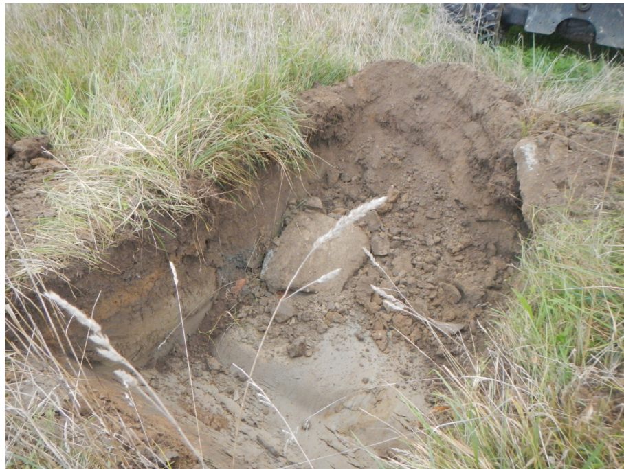
Fotos 3+4: BG Ziegelgarten Nonnenweier, Baggerschurfe am 10.09.2020 Auffüllung in Schurf Nr. 1 mit Betonblöcken
