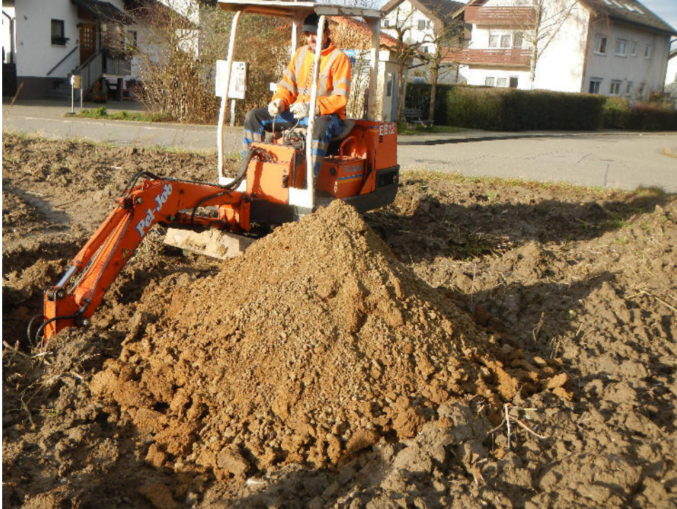
Ausgehobener Auelehm Baggerschurf BS 1 am 31.01.2018
