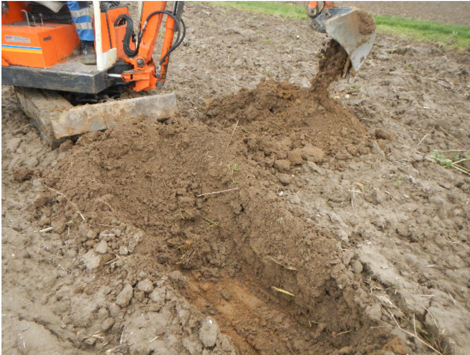
Oberboden Baggerschurf BS 5 am 31.01.2018
