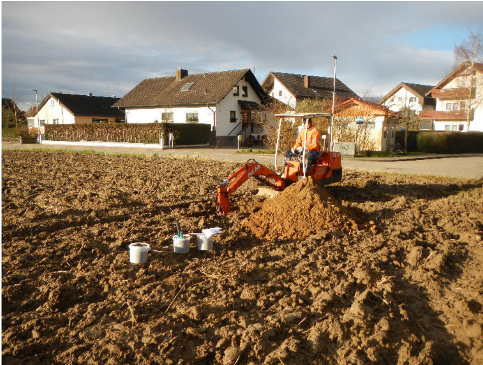
Baggerschurf BS 1 am 31.01.2018
