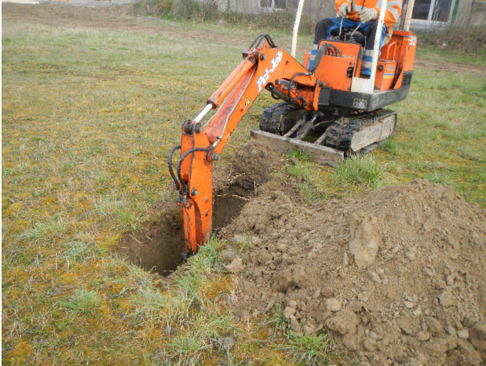
Bindiger Auelehm Baggerschurf BS 1 am 27.03.2018
